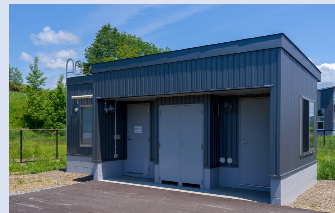
燃焼速度測定用燃焼試験場外観
