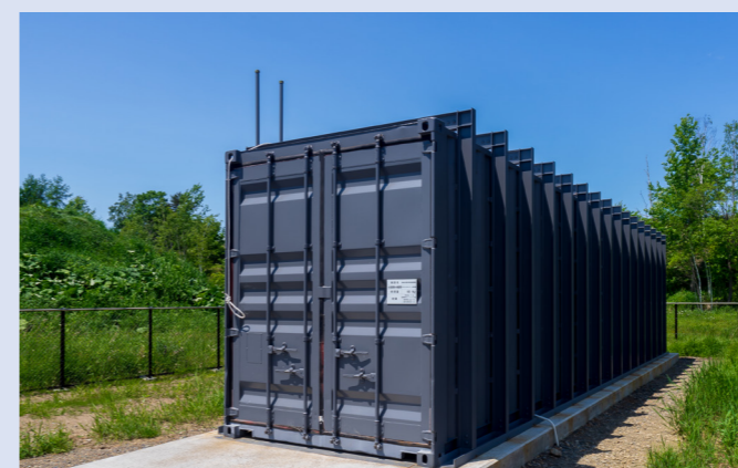
推進力測定用燃焼試験場外観
