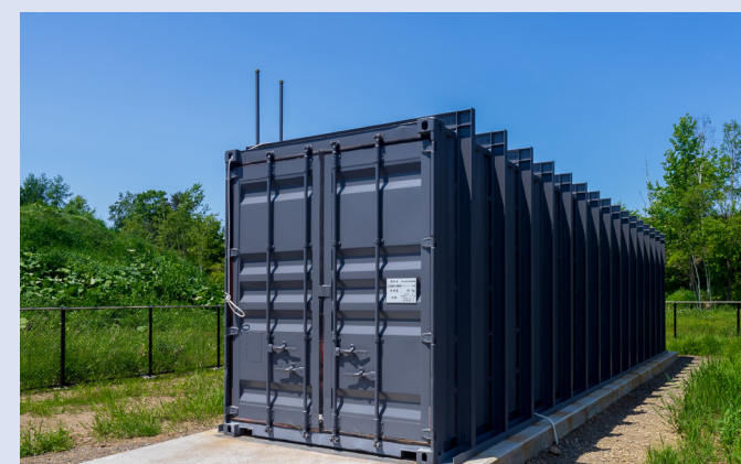
推進力測定用燃焼試験場外観
