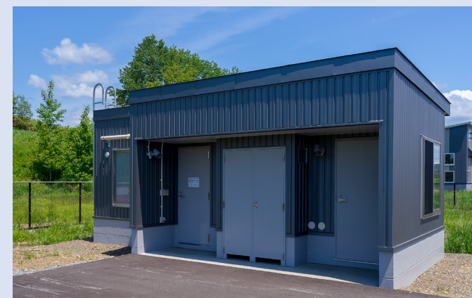
燃焼速度測定用燃焼試験場外観
